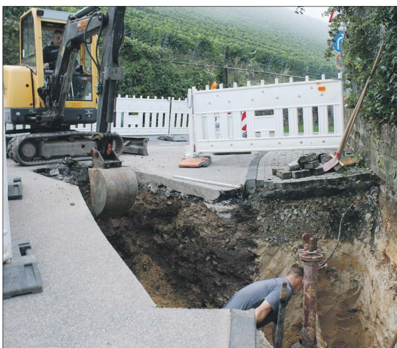
Untergrund. Die Kreuzung der Sickingen- mit der Bergstraße ist tief aufgerissen. Bauarbeiter Benjamin Hörschkes arbeitet an einer Wasserleitung. Foto: Presseamt
