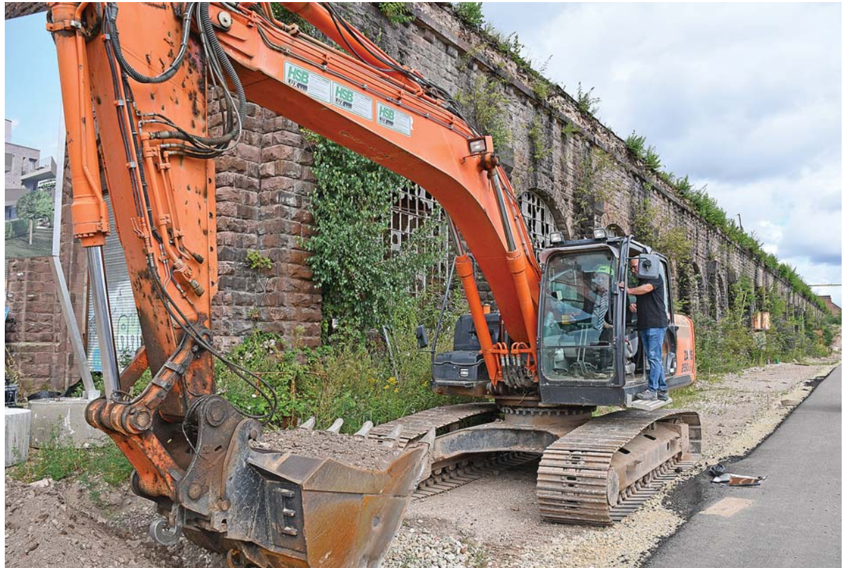
Bei der Arbeit. Baudezernent Andreas Ludwig läutet mit dem ersten Baggeraushub die heiße Phase für die Entwicklung der Industriebrache an der Lokrichthalle. Fotos: Presseamt/kig
