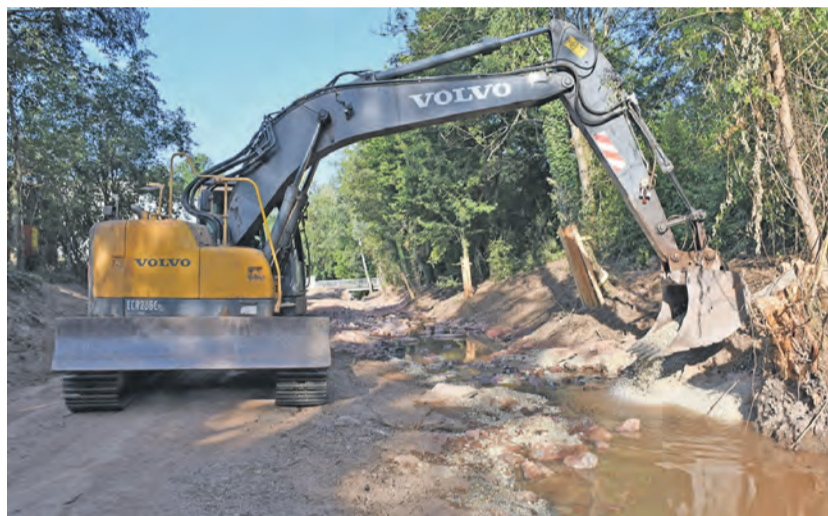
Schichtarbeit. Mit einem Bagger werden Kiesbänke aufgeschüttet, die später Bachforellen zum Abbläuen nutzen können.
