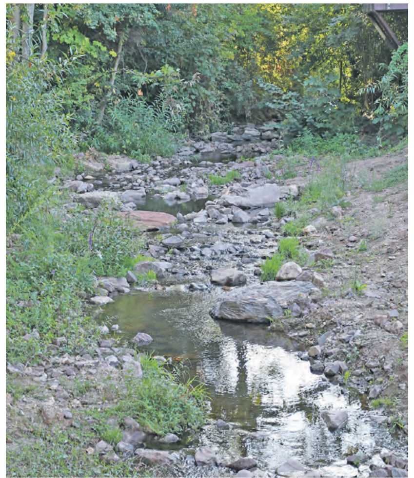
Veränderung. Oberhalb der Mündung des Brettenbachs ist die Renaturierung des Olewiger Bachs abgeschlossen. Trotz Niedrigwasser ist die vielfältige Struktur des Gewässers gut erkennbar. Fotos: Presseamt/kg
