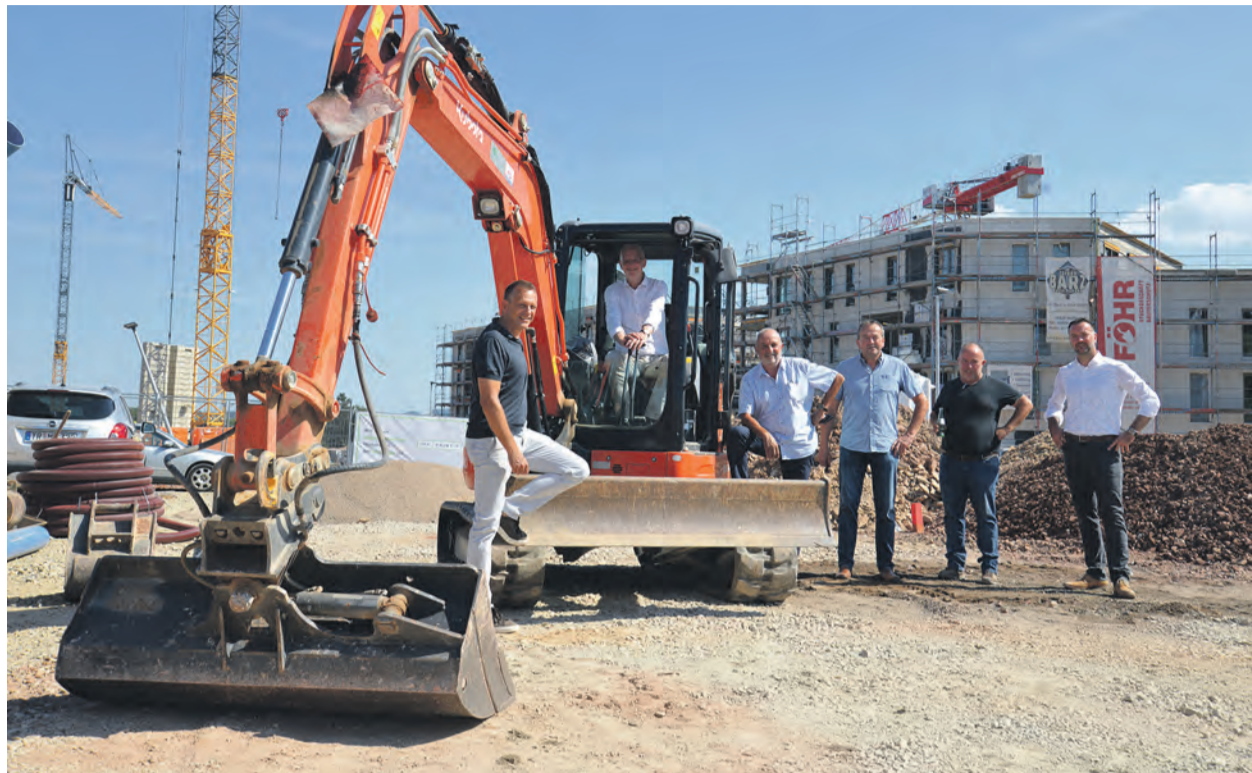
Baustart mit Bagger. Jan Eitel (Imm Prinzip), Oberbürgermeister Wolfram Leibe, Ortsvorsteher Rainer Lehnart, Rainer Zeiler (in Vertretung eines Investors), Polier Horst Lehnen und David Becker (EGP) besichtigen die Baustelle (v. l.).
