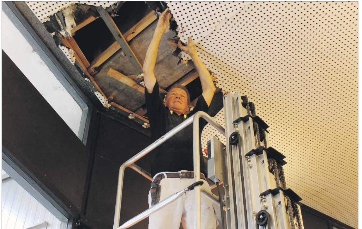
Baustelle Theater. Bert Zonker von der Firma Werner ist an der Decke im Foyer zu Gange, das neu gestaltet wird. Auch der Park hinter dem Haus bekommt ein neues Gesicht. Foto: teatrier
