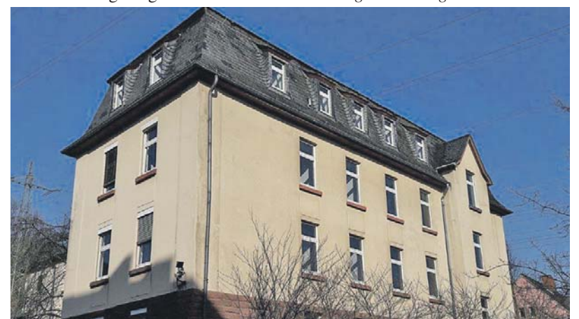
Auf den in den Westen. Der Digital Hub Region Trier wird in der früheren Jägerkaserne in Trier-West/Pallien angesiedelt. Foto: Wirtschaftsförderung
