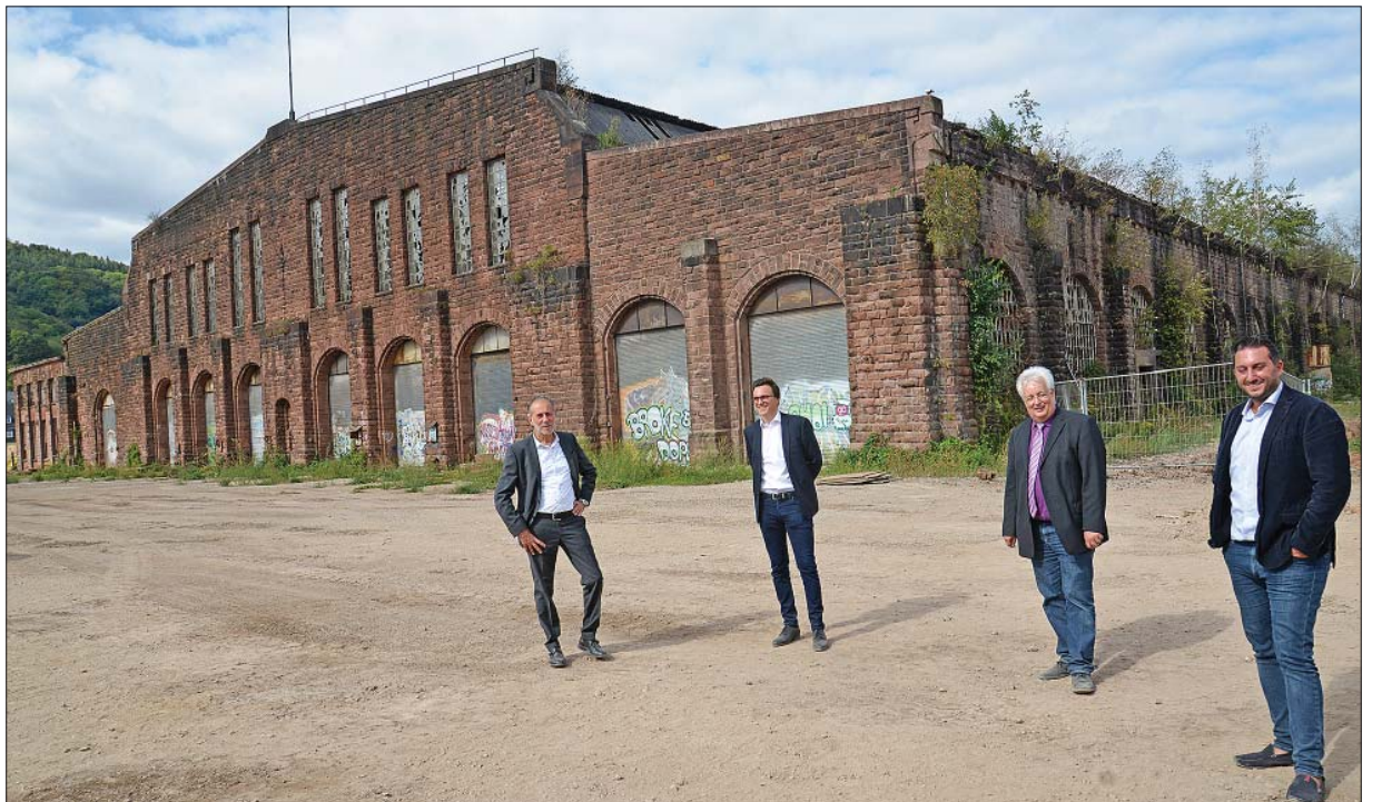
Dornröschenschlaf. Die Geschäftsführer der TW Projekt GmbH Antoine Feidt (links), Maxime d'Hondt (2. v. l.) und Steeve Simonetti (r.) informieren Baudezernent Andreas Ludwig (2. v. r.) vor Ort über ihre Pläne für die mittlerweile zum Teil überwucherte Lokrichthalle und das umgebende Areal. Foto: Presseamt/kg
