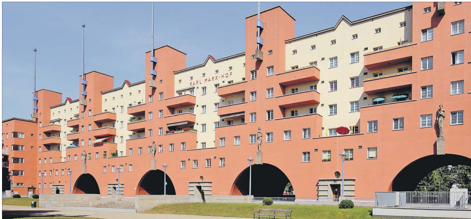
Rot-Weiß-Rot. Der Karl-Marx-Hof in Wien-Döbling wurde um 1930 erbaut und gehört mit ursprünglich 1382 Wohnungen zu den größten und architektonisch markantesten Gemeindebauten der österreichischen Hauptstadt, die bis heute als Meilensteine des sozialen Wohnungsbaus gelten. Das Österreich-Forum Trier widmet dem Karl-Marx-Hof ab 26. Oktober eine Ausstellung in der Viehmarkttherme. Foto: Bwag/Wikimedia
