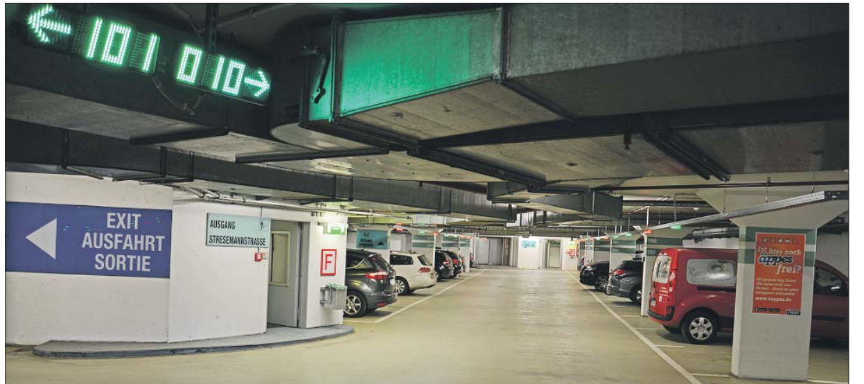
Übersicht. Das Leitsystem in der Tiefgarage am Viehmarkt zeigt die aktuell freien Plätze auf den verschiedenen Parkdecks an. Die je nach Belegung rote oder grüne Einzelplatzanzeige schafft zusätzliche Orientierung. Foto: Presseamt
