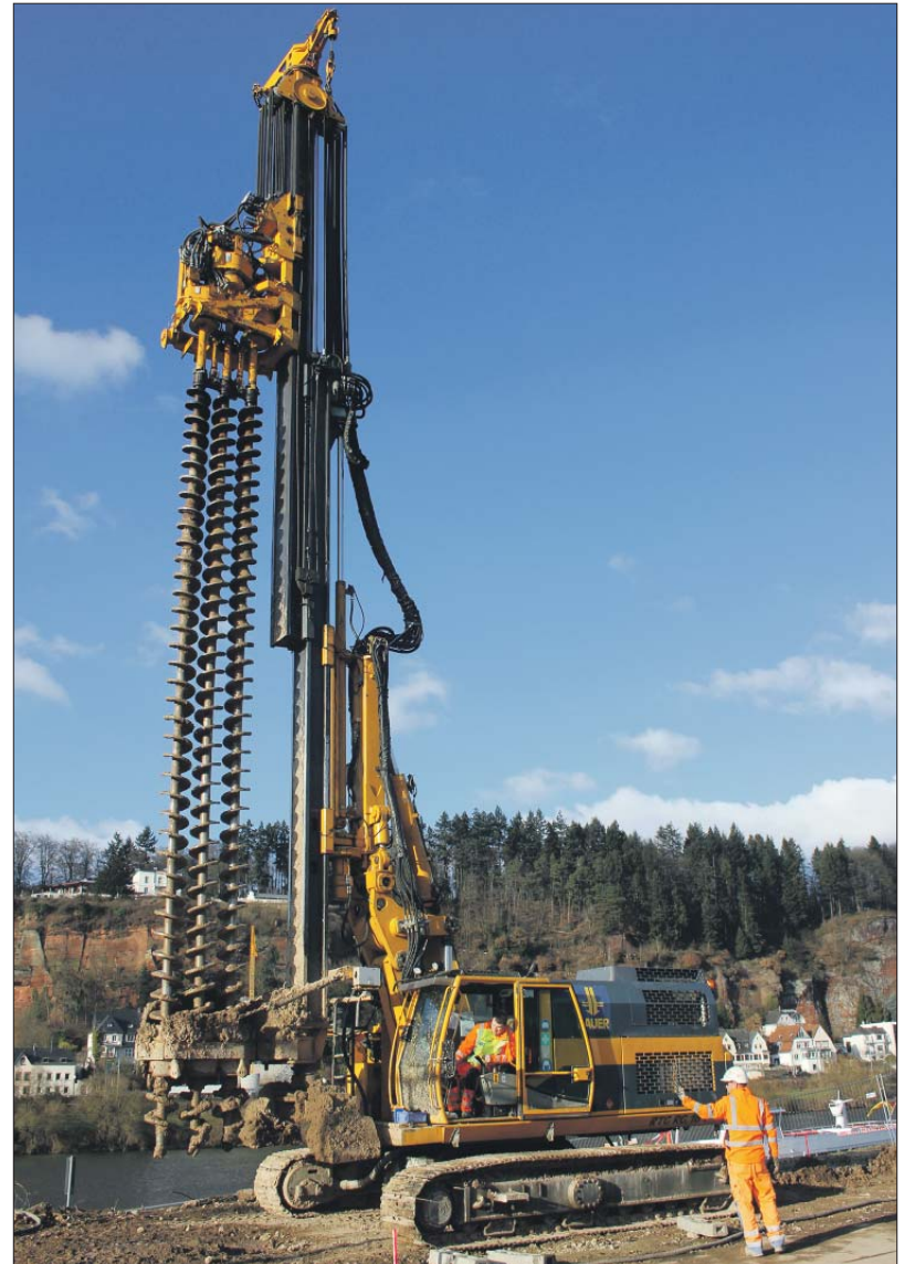
Großes Gerät. Die zwölf Meter langen Bohrer fressen sich ins Erdreich, in das sie ein Zementgemisch einspritzen. So entsteht eine zusammenhängende Dichtwand, die den Deich stabilisiert. Foto: Presseamt
