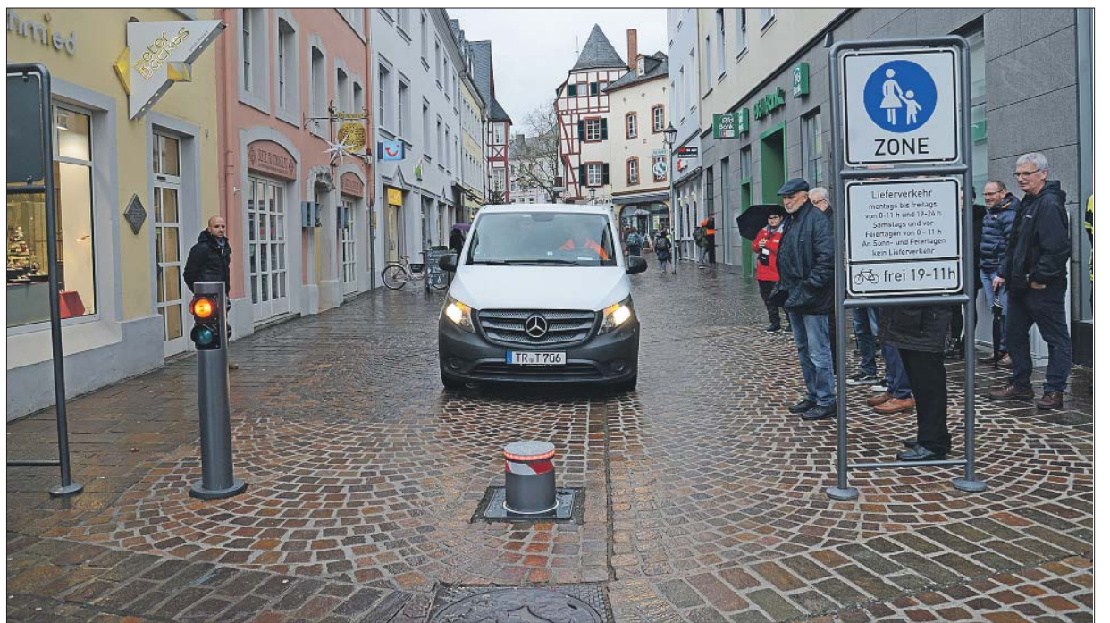
Premiere. Seit Dezember ist die Polleranlage in der Glockenstraße in Betrieb. Sobald ein Auto die unter dem Pflaster eingebaute Induktionsschleife überfährt, senkt sich der Poller automatisch ab. Foto: Presseamt/bau
