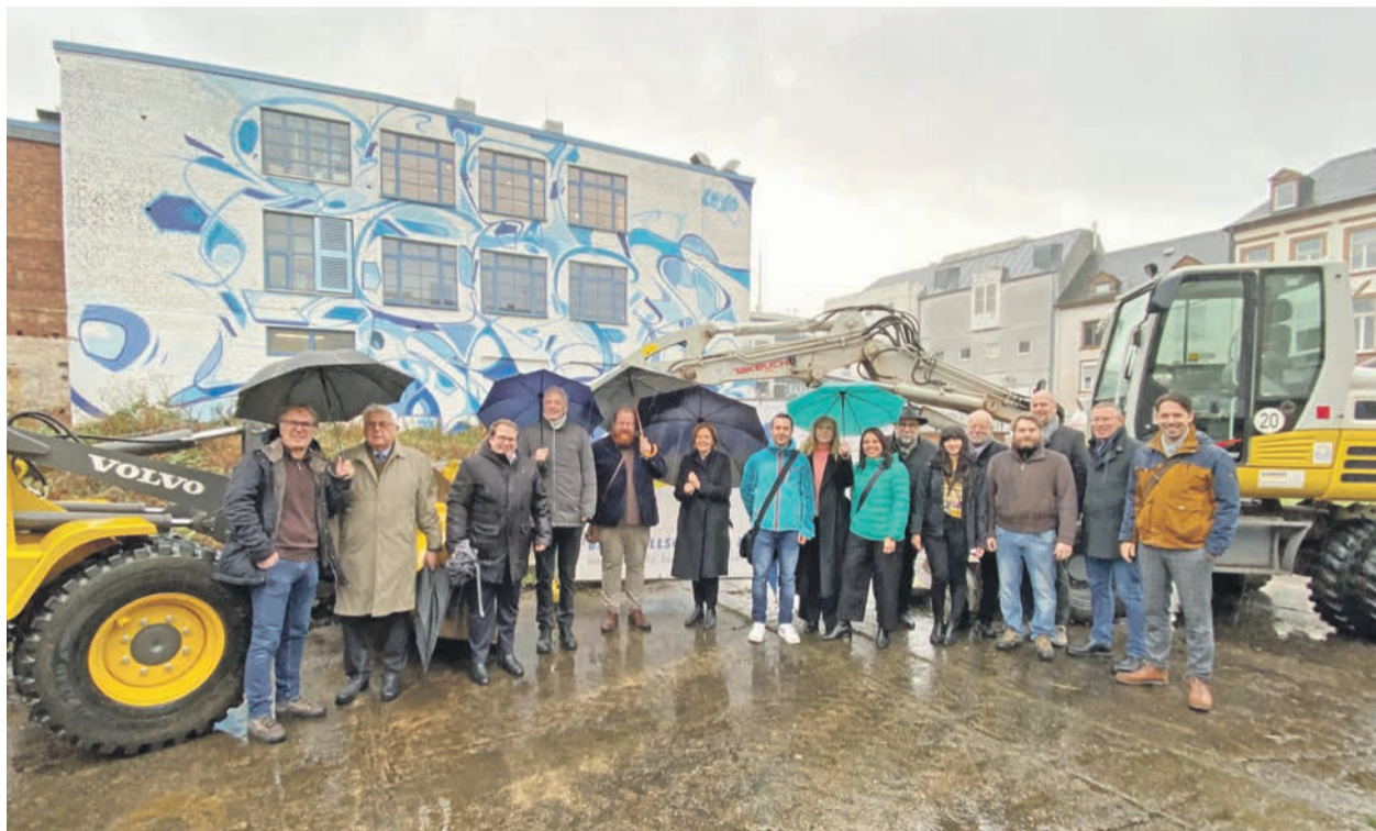
Künftige Baustelle. Auf diesem Areal wird der neue Veranstaltungssaal der Tufa entstehen, der 380 Sitzplätze umfassen soll. Zum Start dieses Großprojekts trafen sich unter anderem Ministerpräsidentin Malu Dreyer, OB Wolfram Leibe (4. v. l.), Kulturdezernent Markus Nöhl (5. v. l.), ADD-Präsident Thomas Linnertz (3. v. l.) sowie weitere Beteiligte. Foto: Presseamt/gut
