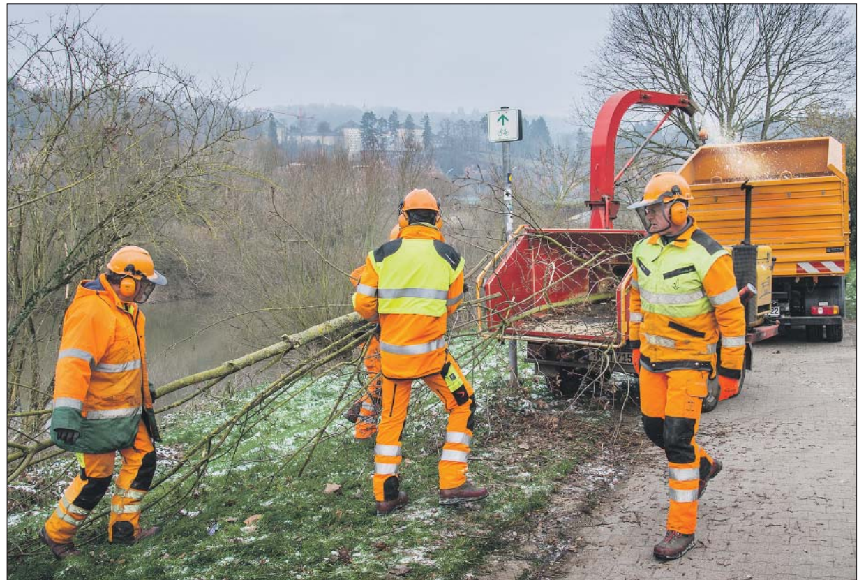
Einsatz bei Minusgraden. Valentin Benzkirch, Jörg Wollscheid (verdeckt), Oliver Kolz und Hans-Dieter Schmitz (v. l.) von der Baumpflegekolonne des Grünflächenamts schneiden das Gehölz am Moselufer zurück. Foto: Presseamt
