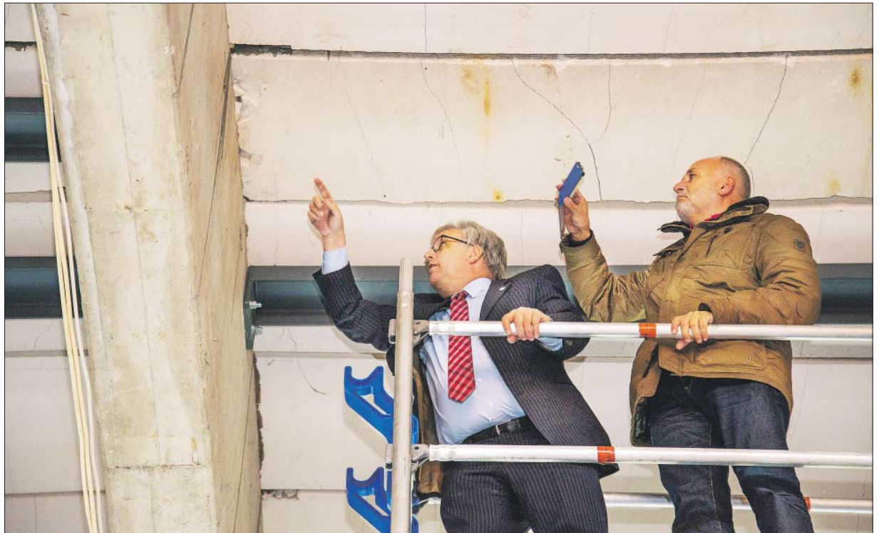
Ortstermin. Baudezernent Andreas Ludwig (l.) und Rainer Lehnart, Ortsvorsteher von Feyen/Weismark, begutachten die beschädigten Gasbetonplatten im Dach der Bezirkssporthalle aus nächster Nähe. Foto: Presseamt
