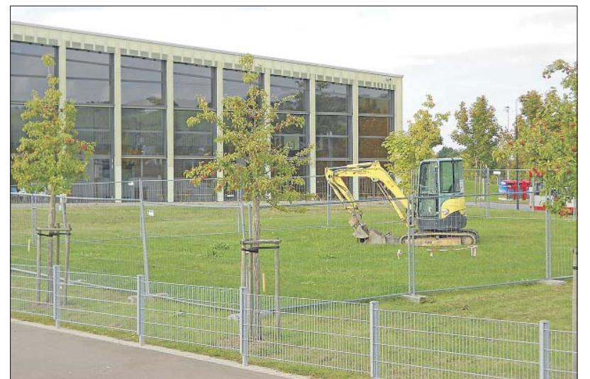
Vorbote. Der am Freitag angelieferte Bagger vor der Grundschule verweist auf den künftigen Standort des Erweiterungsbaus. Foto: Gebäudewirtschaft
