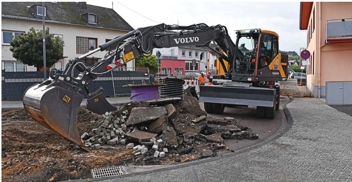
Aufbruch. Im letzten Abschnitt des Straßenausbaus Zum Pfahlweiher wird die alte Fahrbahndecke an der Einmündung Sandbach abgetragen. Zur Finanzierung werden einmalige Ausbaubeiträge von den Anliegern erhoben. Foto: PA/kig
