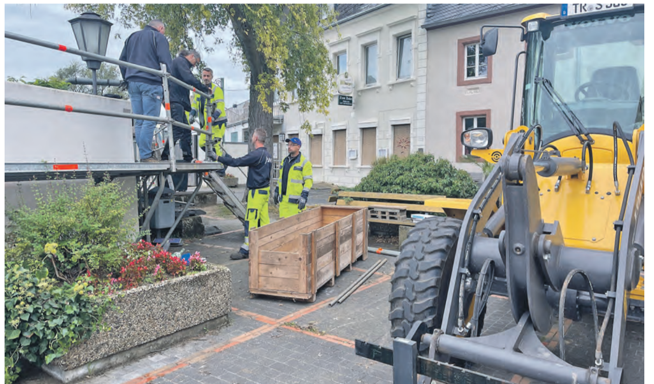
Aufgestockt. Mit Hilfe mobiler Elemente wird die Hochwasserschutzmauer am Pfälzeler Spieles erhöht. Entlang des Radweges schützt ein Dammbalkensystem (Foto unten) die dahinterliegenden Gärten und Häuser. So ertüchtigt ist Pfälzel gegen ein 100-jährliches Hochwasser mit einem Pegel von bis zu 11,80 Meter geschützt.
