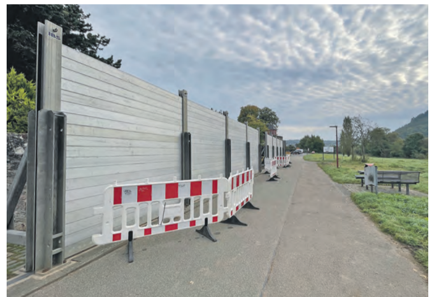
Aufgestockt. Mit Hilfe mobiler Elemente wird die Hochwasserschutzmauer am Pfälzeler Spieles erhöht. Entlang des Radweges schützt ein Dammbalkensystem (Foto unten) die dahinterliegenden Gärten und Häuser. So ertüchtigt ist Pfälzel gegen ein 100-jährliches Hochwasser mit einem Pegel von bis zu 11,80 Meter geschützt.
