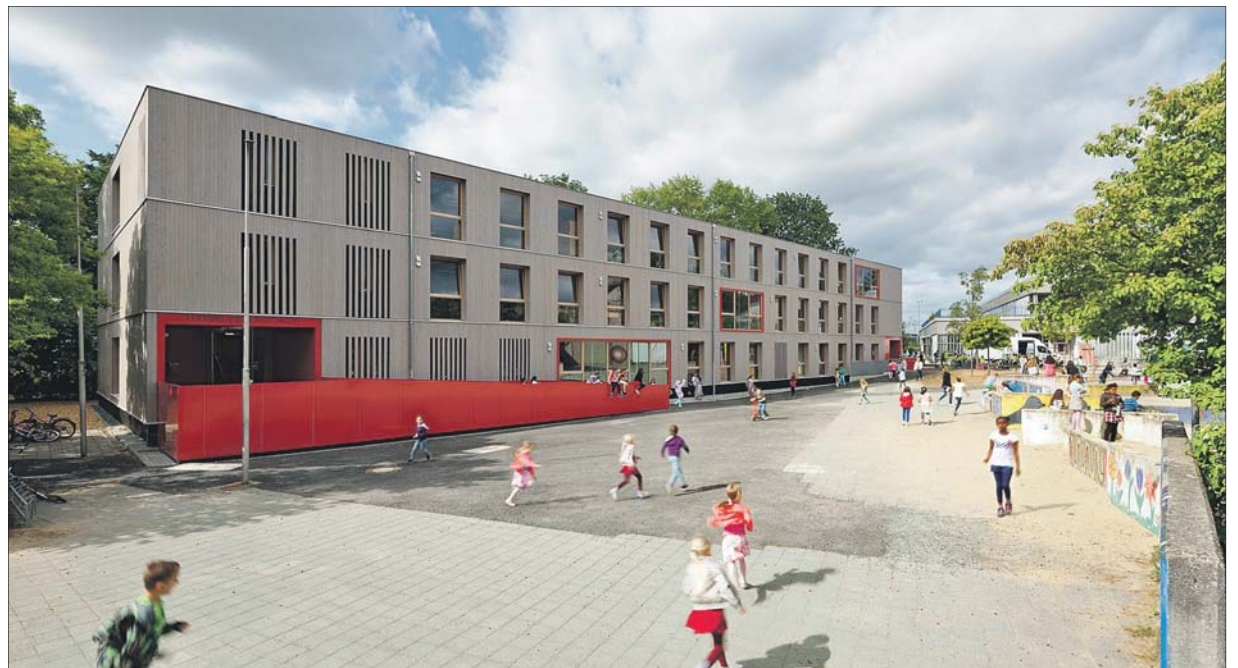
Beispiel. Der Unterricht an der Ludwig-Weber-Grundschule in Frankfurt am Main findet während des Neubaus des Hauptgebäudes in diesem dreigeschossigen Holzrahmenmodulbau statt. Ein ähnliches mobiles Schulhaus ist als Ausweichquartier für die IGS am Standort Wolfsberg im Gespräch. Foto: Thomas Ott Mühlthal/Werk.um Architekten
