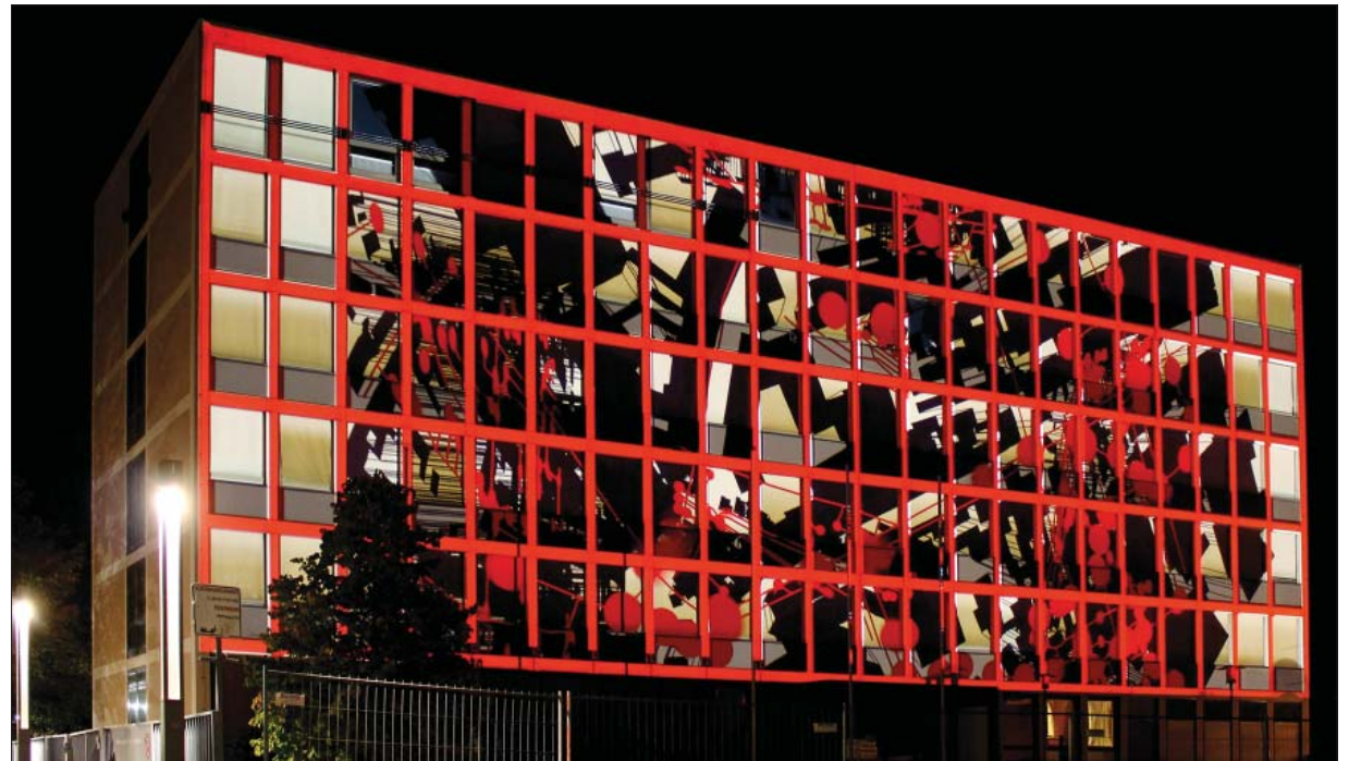
Hingucker. Ein optisches Highlight der ersten Design- und Kulturtag Trier wird die audiovisuelle Gebäudeprojektion „Binary Patina“ an dem mehrstöckigen Bürogebäude am Irminenfreihof 10. Foto: Hochschule Trier
