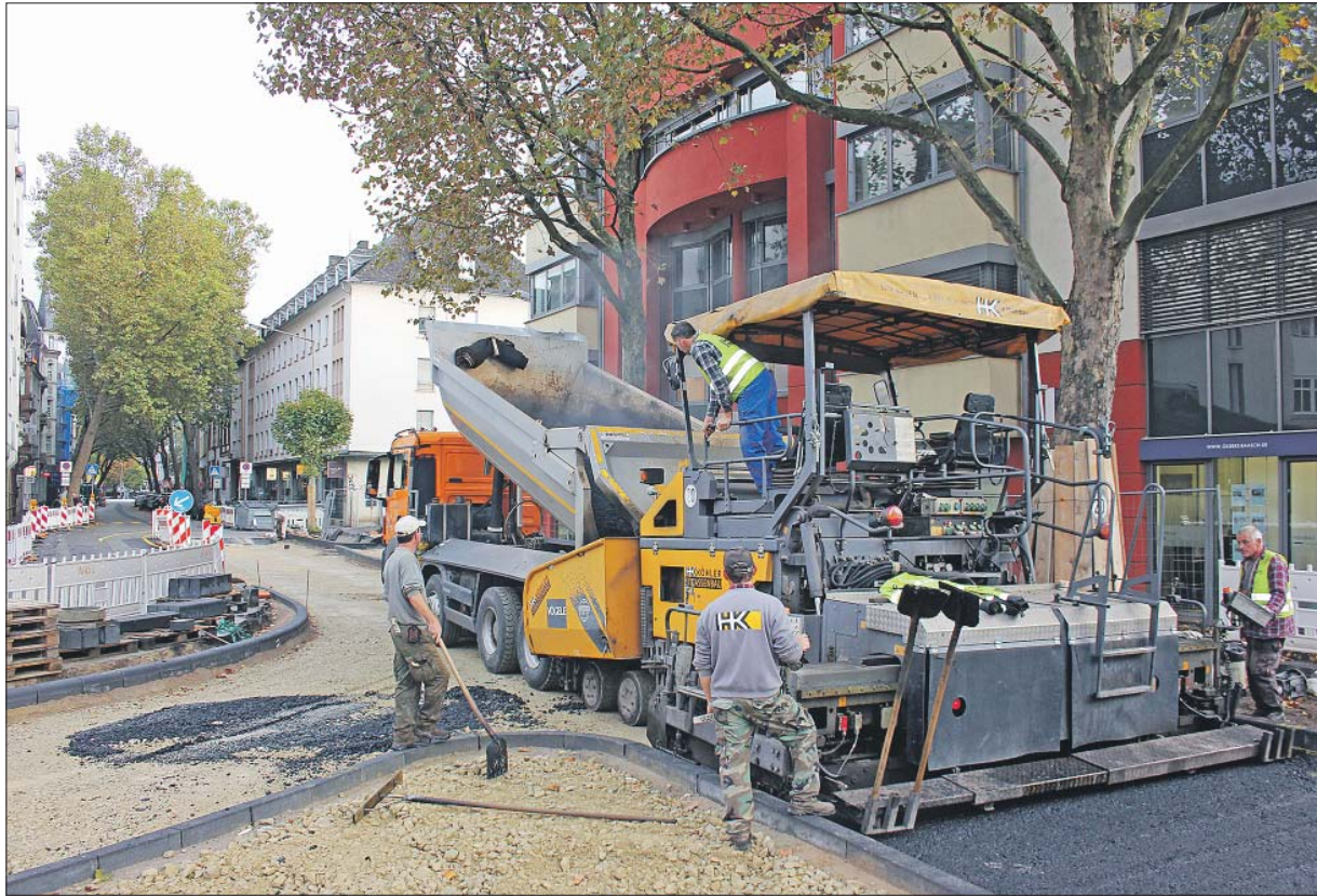
Heißes Material. Die Asphaltierungsarbeiten der Einmündung Bruchhausenstraße auf den Pferdemarkt sind in vollem Gange. Bald ist die Durchfahrt aus Richtung Moselstraße wieder frei. Später folgt die Pflasterung der Gehwege und der Verkehrsinsel (vorne), deren Konturen durch die Bordsteine bereits klar erkennbar sind. Foto: PA
