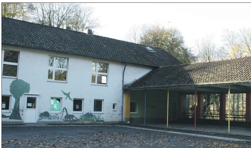
Hängepartie. Seit einem Jahr ist die Egbert-Grundschule im Gartenfeld wegen Schimmelschäden geschlossen. Noch ist völlig offen, ob die Schule saniert, durch einen Neubau an dieser oder einer anderen Stelle ersetzt oder dieser Standort komplett aufgegeben wird. Archivfoto: PA
