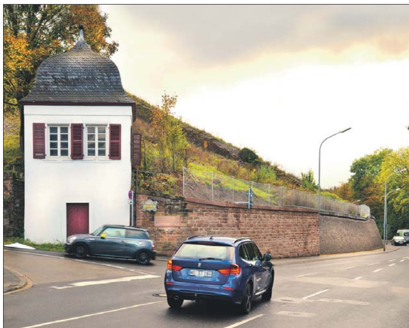
Aufatmen bei den Autofahrern aus den Höhenstadtteilen: Nach mehr als einem Jahr sind die Bauarbeiten an der Weinbergsmauer entlang der Olewiger Straße abgeschlossen und die einspurige Verkehrsführung aufgehoben, die immer wieder für lange Staus in der Rush-Hour gesorgt hatte. Der letzte Abschnitt der Bauarbeiten war mit zusätzlichen Belastungen für das Gartenfeld verbunden. Wegen der Sperrung des letzten Teils der Sickingenstraße Richtung Innenstadt führte die Umleitungsstrecke durch dieses Wohngebiet im Osten der Stadt. Foto: PA
