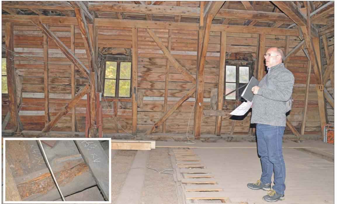
**Späne im Balken.** Projektleiter Jürgen Eckstein erläutert im Obergeschoss des geschlossenen Exhaus-Mittelteils, dass dort zahlreiche Holzbalken vom sogenannten Hausschwamm befallen sind. Hierbei handelt es sich um einen Pilz, der die Holzbalken geradezu zerfrisst (kleines Bild). Laut Eckstein werden die befallenen Stücke herausgesägt und durch neue ersetzt. *Fotos: Presseamt/gut*
