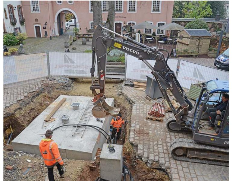
**Unterbau.** Rund 130 Tonnen Beton wurden in der Liebfrauenstraße für das Fundament der Hochsicherheitspoller verbaut. Die Baugrube wird jetzt wieder verfüllt und mit einer provisorischen Asphaltdecke geschlossen. Foto: PA/kig
