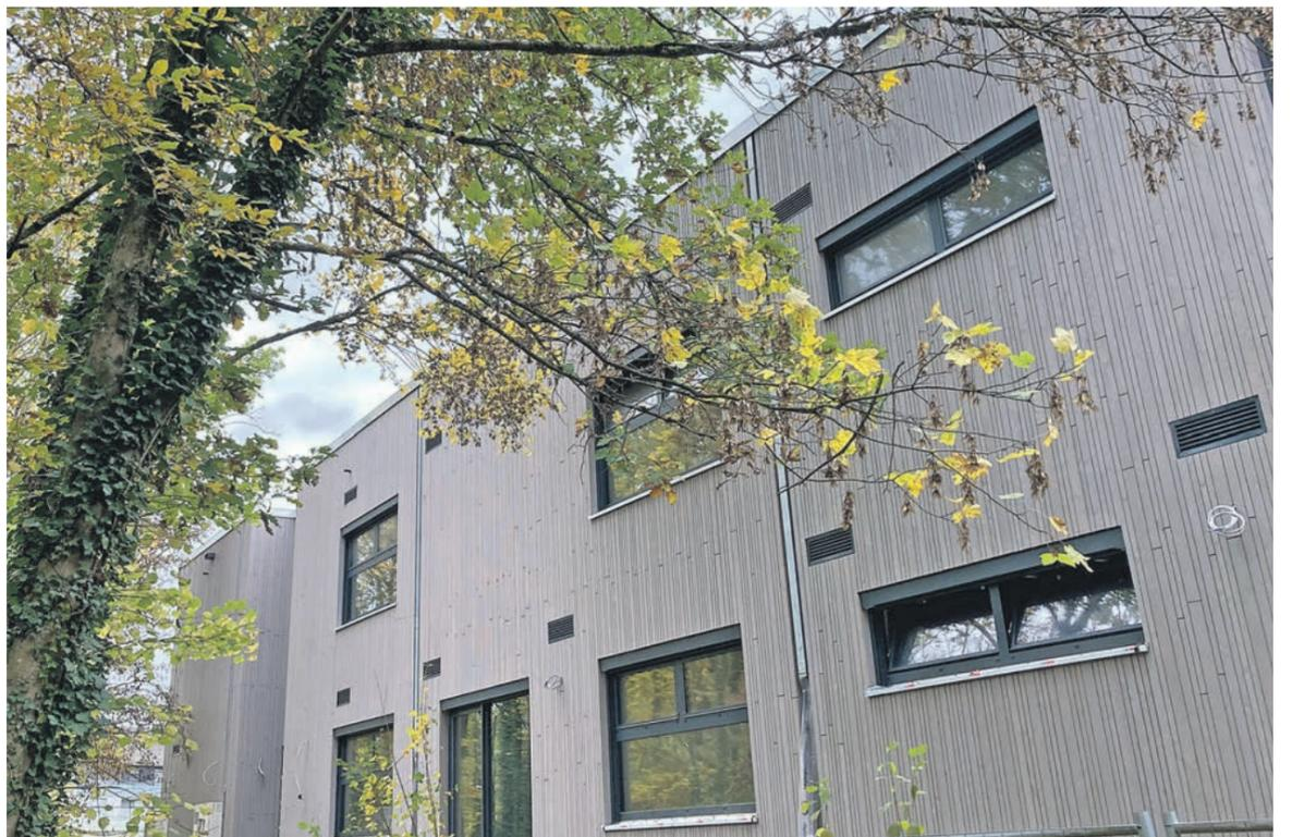
**Neubau.** Die Kita St. Adula wird unter Leitung des städtischen Hochbauamts als Holzrahmenkonstruktion neu errichtet, ergänzt durch Betonelemente. Die Fassade (Bild oben) ist mit Lärchenholz verkleidet, das auch durch den Kontrast zu den dunklen Metallfenstern gestalterische Akzente setzt. Holz wird auch im Inneren des Gebäudes vielfach eingesetzt, unter anderem bei den schallabsorbierenden Deckenelementen (Foto unten). Fotos: Hochbauamt
