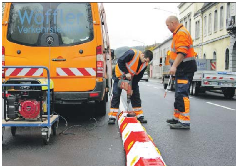
In der Zurmaiener Straße hat die Firma Wöfler Verkehrstechnik im Auftrag des städtischen Tiefbauamts neue Fahrbahnteiler installiert. Die alten mussten entfernt werden, da sie mit nur neun Zentimetern Höhe häufig bei gefährlichen Wendemanövern von großen Fahrzeugen überfahren wurden. Die rot-weißen Leitborde aus stabilem Recycling-Material, die jetzt zwischen Nordbad und Burger King befestigt wurden, haben eine Höhe von 20 Zentimetern und sind durch den Einsatz von Reflektoren auch in der Nacht gut sichtbar. Foto: PA
