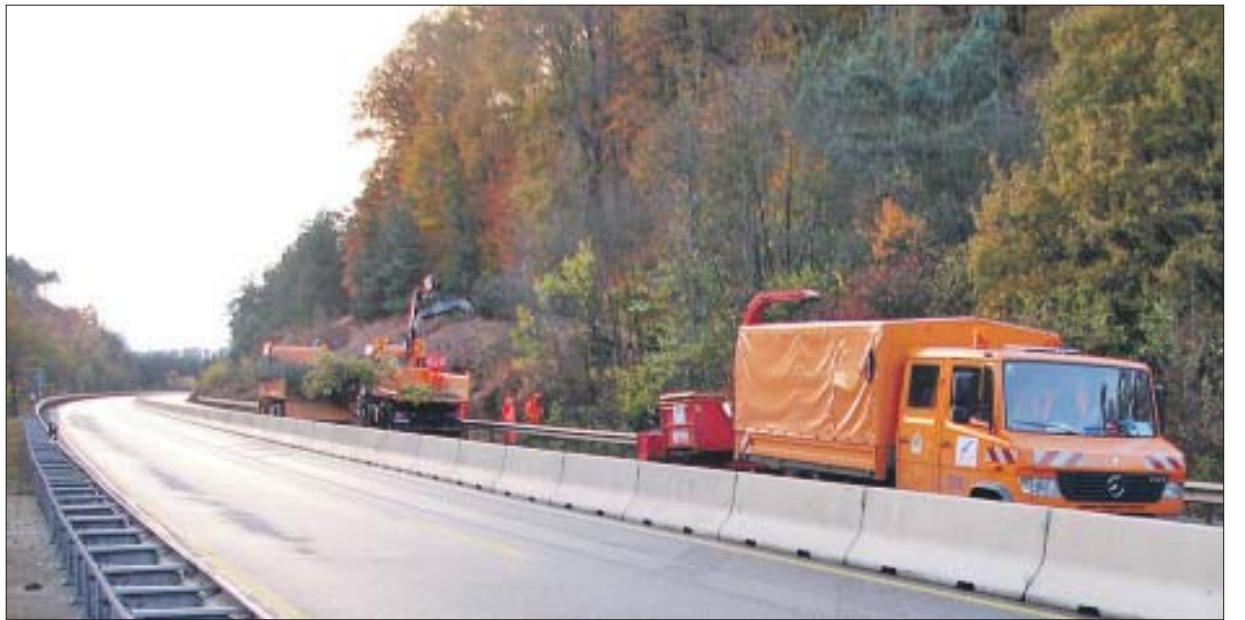
Die umfangreichen Waldpflegearbeiten rund um die Bundesstraße B 52 sind am Sonntag erfolgreich und unfallfrei verlaufen. Die Straße war ab Mitternacht von der Abfahrt Ehrang bis zur Ausfahrt Trier der A 64 aus Sicherheitsgründen in beiden Richtungen gesperrt. Rund 50 Personen und verschiedene Spezialmaschinen waren auf der Fahrbahn und in den angrenzenden Wäldern bis nach Einbruch der Dunkelheit aktiv, wobei der anfangs starke Regen die ohnehin gefährlichen Baumfällungen erschwerte. „Durch die gute Zusammenarbeit zwischen den Mitarbeitern der städtischen Forstreviere, verschiedenen Unternehmen, der Straßenmeisterei Schweich und der Firma Wöfler konnte flexibel auf verschiedene Herausforderungen reagiert werden, die bei einer derartig groß angelegten Maßnahme fast unvermeidlich sind“, lautete das Fazit von Kerstin Schmitt, Försterin im Revier Weisshaus/Pfalzel. Foto: Forstrevier
