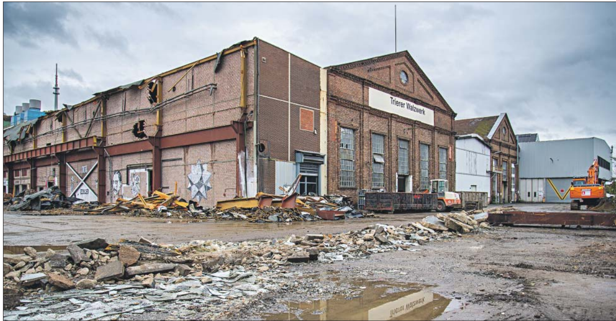
Umbruch. Die Fabrikhallen des stillgelegten Walzwerks in Kürenz sollen zum Teil erhalten bleiben. Foto: Presseamt
