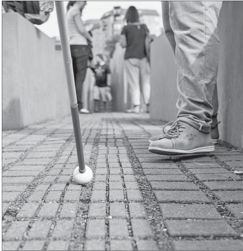
Taktil. Ein Leitsystem mit unterschiedlichen Bodenbelägen ist Voraussetzung, damit sehbehinderte Menschen sich mit einem Langstock selbständig in der Stadt bewegen können. Fotos: Andi Weiland/gesellschaftsbilder.de; PA
