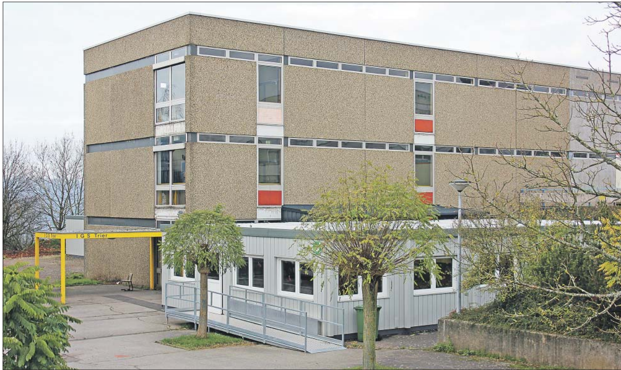
Provisorium. Während der Sanierung der Schulgebäude sind Fachräume, die Mensa und Verwaltungsbüros der IGS in Stahlcontainern untergebracht, die ab dem kommenden Jahr durch einen Holzmodulbau ersetzt werden sollen. Foto: PA
