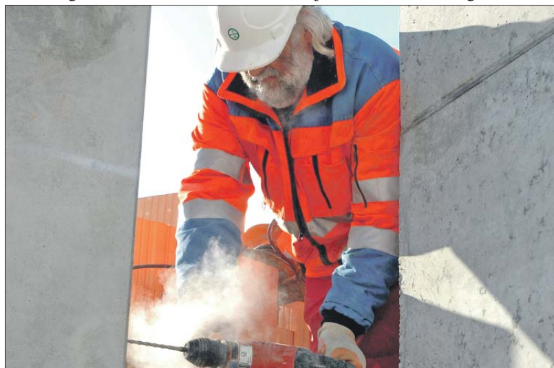
Zwangspause. Bauarbeiter können im Winter nicht arbeiten und werden entlassen – das treibt die Arbeitslosenzahl nach oben. Foto: Paul Meister/pixelio
