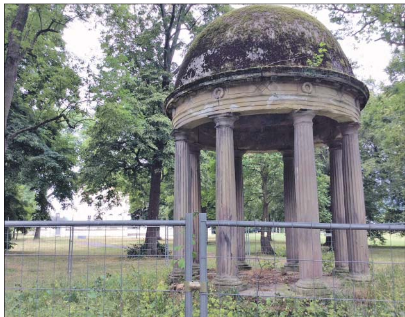
Verwunschen. Die Treppen sind mit Unkraut überwuchert, die Kuppel mit Moos überzogen: Der Restaurierungsbedarf für den Monopteros im Schlosspark Monaise ist kaum zu übersehen. Foto: Trier-Gesellschaft
