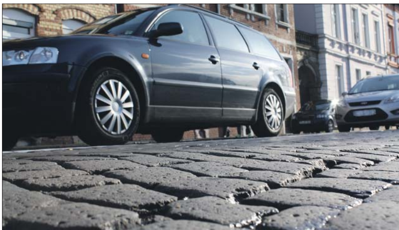
Lautes Pflaster. Der Straßenbelag in der Luxemburger Straße soll ausgetauscht und die Lärmbelastung dadurch deutlich verringert werden. Foto: PA
