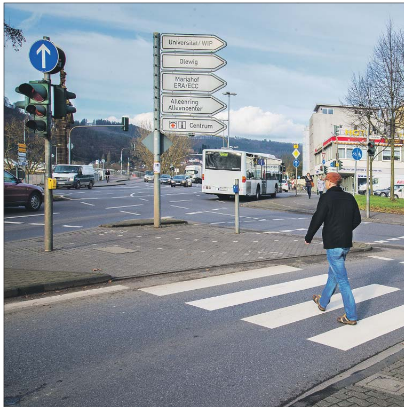
Auf Streifen. Fußgängerüberwege ohne eigene Beleuchtung, wie hier an der Rechtsabbiegespur von der Moseluferstraße in die Südallee, entsprechen nicht mehr den geltenden Richtlinien. Foto: Presseamt
