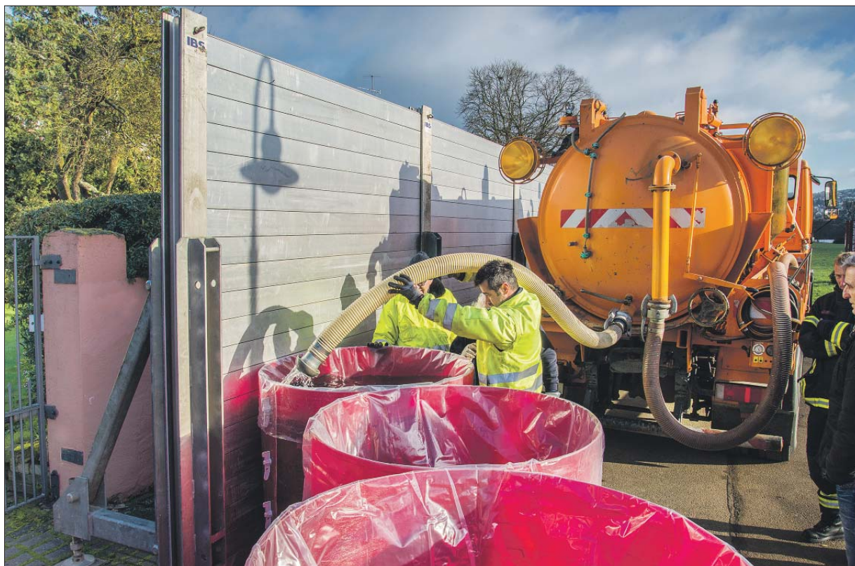
Doppelt hält besser. Die mobile Schutzwand steht. Davor werden die Aquariwa-Behälter mit Wasser gefüllt. Im Ernstfall bildet auch dieses schnell aufgebaute System einen Schutz gegen das Hochwasser. Foto: Presseamt
