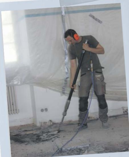
April: Bevor der neue Boden kommt, muss der alte aufgestemmt werden.
