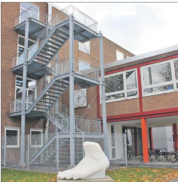
Feuerleiter. Die neue Außentreppe am FWG dient als alternativer Fluchtweg im Fall eines Brandes. Foto: PA
