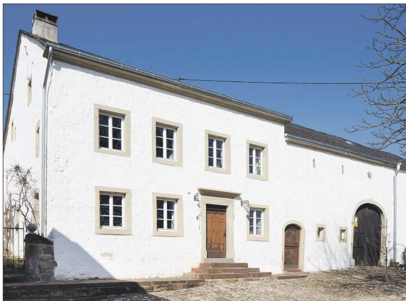
Schmuckstück. Der Streckhof aus dem 18. Jahrhundert in Merzkirchen-Portz wurde mit viel Liebe zum Detail vorbildlich saniert und erhielt eine Anerkennung beim Wettbewerb um den Sparkassen-Denkmalpflegepreis. Foto: Sparkasse
