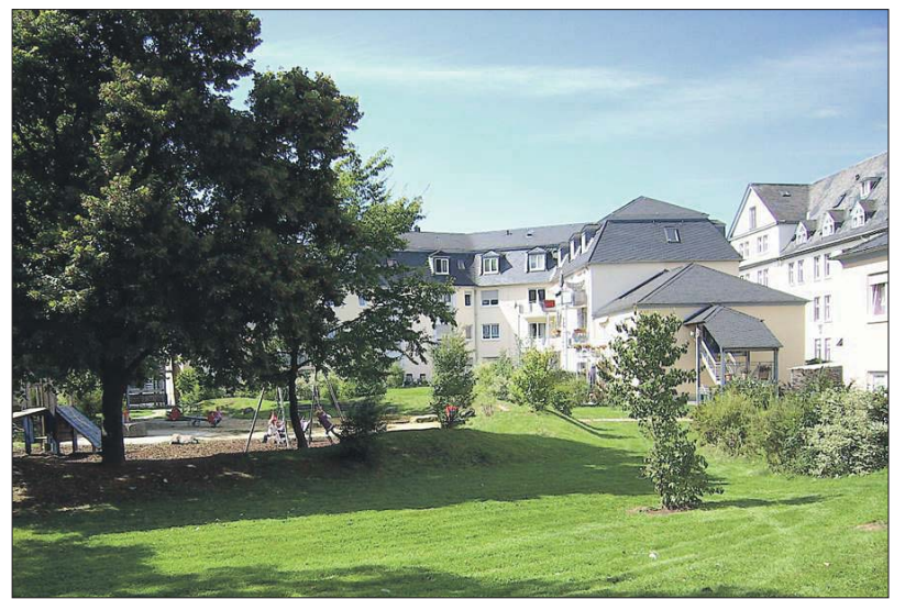
Trendwende. 1985 präsentierte sich ein Wohnhaus in der Ambrosiusstraße in einem desaströsen Zustand (Bild oben). Der Abriss und Neubau der Anlage durch die Wogebe vor zehn Jahren brachte große Fortschritte. Fotos: Wogebe
