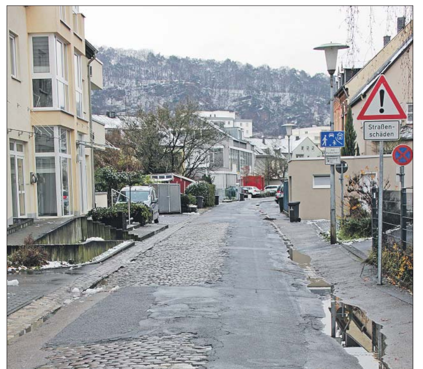
Sanierungsfall. Die als Spielstraße ausgeschilderte Benediktinerstraße im Maarviertel weist erhebliche Fahrbahnschäden auf. Foto: Presseamt
