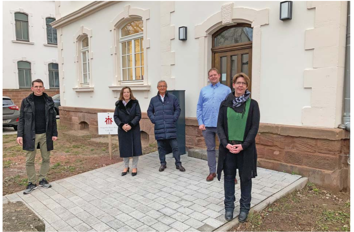
Startschuss. Bürgermeisterin Elvira Garbes (2. v. l.) verschafft sich vor Ort einen Eindruck vom neuen Projekt für wohnungslose junge Menschen in dem sanierten Gebäude Gneisenaustraße 44. Mit dabei sind auch der städtische Jugendamtsleiter Carsten Lang, Dr. Manfred Bitter (Herbert und Veronika Reh Stiftung) sowie Michael Schneider und Alexa Lichter vom freien Träger Don Bosco Helenenberg (v. l.). Foto: Sozialdezernat
