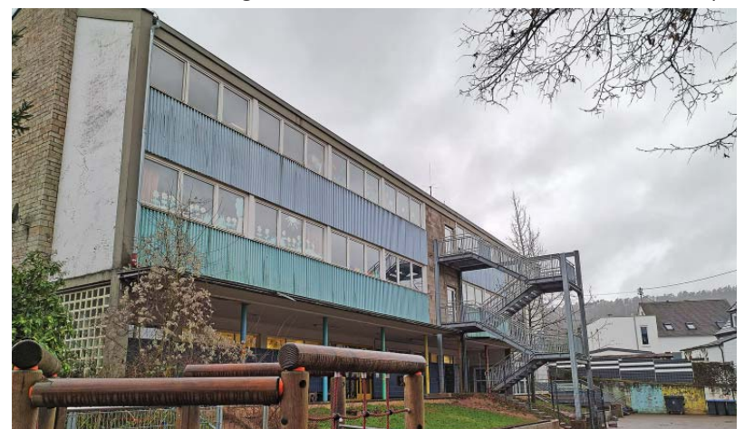
Sanierungsfall. Das 57 Jahre alte Gebäude der Grundschule in Quint muss grundlegend saniert werden. Foto: Presseamt/rwa
