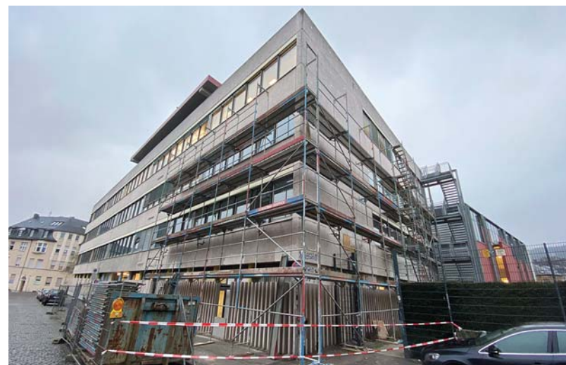
Startschuss. Mit dem Aufstellen des Gerüsts begannen letzte Woche die Bauarbeiten am AVG-Gebäude in der Innenstadt. Foto: PA/rwa
