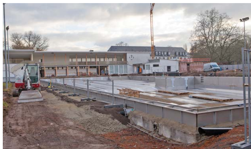
Im Bau. Das neue Schwimmbecken wird voraussichtlich noch im Februar fertig. Foto: Stadtwerke
