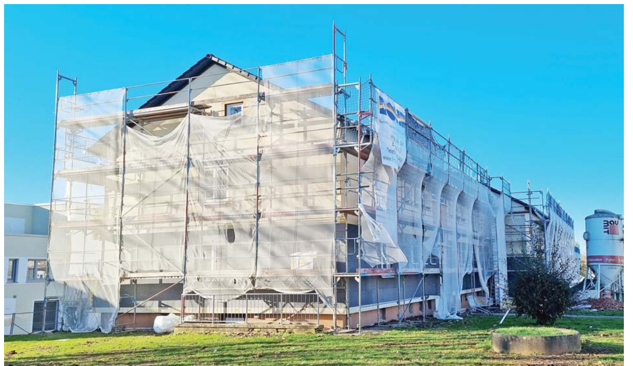
Modernisierung. In mehreren Wohngebäuden an der Louis-Pasteur-Straße stehen Bauarbeiten im Auftrag der WiT an. Diese Immobilien im Burgunderviertel grenzen teilweise direkt an den Neubaukomplex der EGP (links) an. Foto: PA/pe
