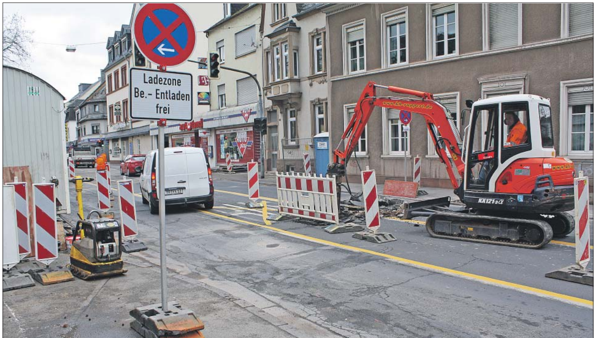
Aufbruch. Der Platz für den fließenden und ruhenden Verkehr ist während der Tiefbauarbeiten in der Paulinstraße mitunter knapp bemessen. Foto: Presseamt
