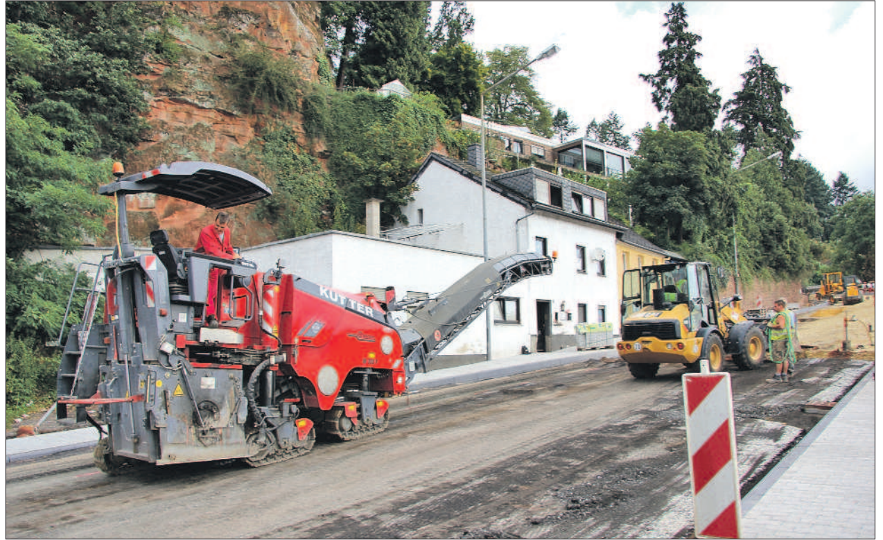
Bild oben: Fahrbahnerneuerung auf der Bitburger Straße. Mit einer Fräse wird im Abschnitt unterhalb der Napoleonsbrücke zunächst der alte Asphaltbelag entfernt. Die Gehwege auf beiden Seiten wurden bereits bis auf die Höhe Reverchonweg frisch gepflastert. Foto: PA
