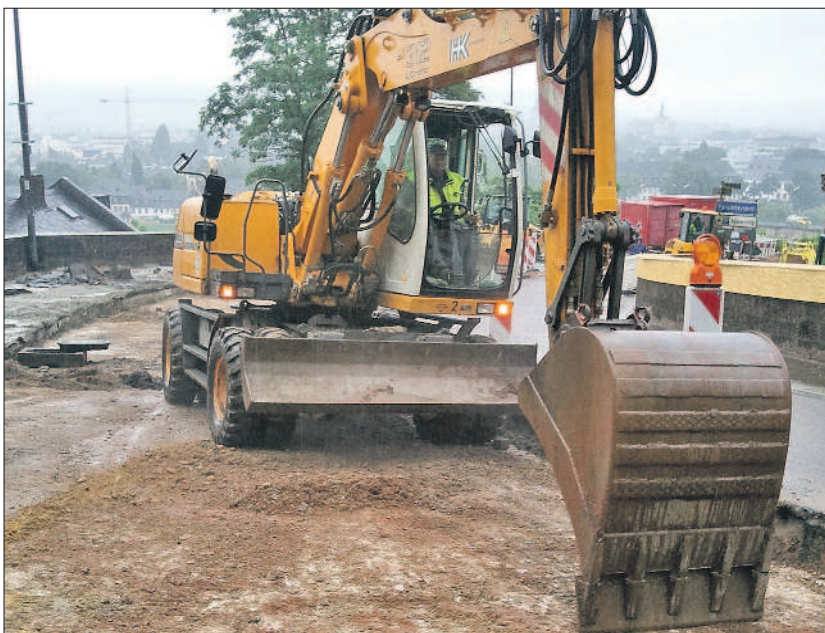
Schichtarbeit. Der Asphalt auf der Napoleonsbrücke wird entfernt Foto: TBA
