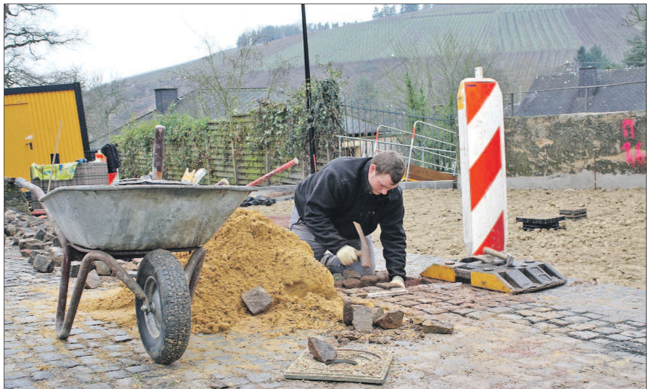
Dank des bisher milden Winters gehen die Sanierungsarbeiten in der Straße „Auf der Ayl“ im Stadtteil Olewig zügig voran. Bis Ende April soll das Projekt abgeschlossen sein. Die Straße war vor Beginn der Bauarbeiten im Februar 2011 in einem schlechten baulichen Zustand und nicht mehr verkehrssicher. Von der Olewiger Straße bis zur Kirche sowie hinter der Kirche bis zur Auffahrtsrampe zur Grundschule erhält die Straße eine Asphaltbefestigung. Auf den anderen Abschnitten wird eine Betonpflasterdecke verlegt (Foto). Die Gesamtkosten der Bauarbeiten betragen voraussichtlich 831 000 Euro. Nach der Fertigstellung wird die Straße zu einer verkehrsberuhigten Zone. Foto: PA
