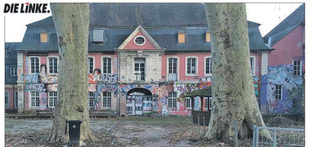
Vor einem Jahr wurde das Exhaus aufgrund baulicher Mängel geschlossen. Es wird endlich Zeit für eine nachhaltige Lösung. Unsere Fraktion setzt sich weiterhin dafür ein. Foto: Linke Linksfraktion im Stadtrat
