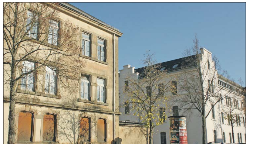
Kontraste. Nicht zuletzt dank der Fördergelder aus dem Programm Soziale Stadt wurde in Trier-West ein Gebäude der Gneisenaukaserne (r.) für das Jobcenter umgebaut. Die Nutzung der Nachbarimmobilie ist noch offen. Foto: PA
