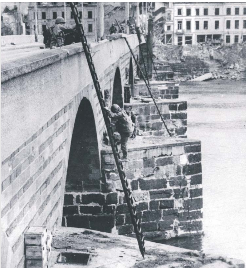
Keine Explosion. US-Pioniere entschärfen am 2. März 1945 den Sprengstoff, mit dem die Römerbrücke gesprengt werden sollte.
