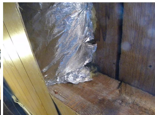
Abb.: Aufbau der Dacheindeckung Abb.: alukaschierte Mineralwolle im Dach
