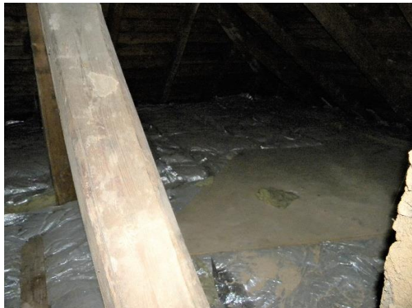
Abb.: Mineralwollendämmung im westlichen Raum Abb.: keine Spuren zu sehen
