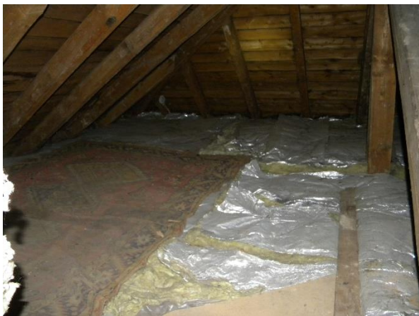
Abb.: Mineralwollendämmung im westlichen Raum Abb.: keine Spuren zu sehen
