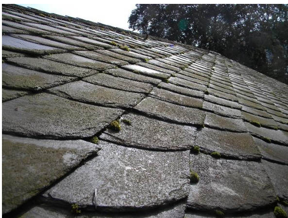
Abb.: noch dicht liegende Schieferdeckung
