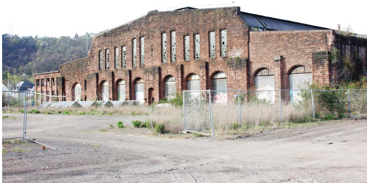
Industriedenkmal. Das frühere Eisenbahnausbesserungswerk mit der Lokrichthalle (Foto) ist eine der wichtigsten Entwicklungsflächen beim Stadtbau in Trier-West. Foto: Presseamt
