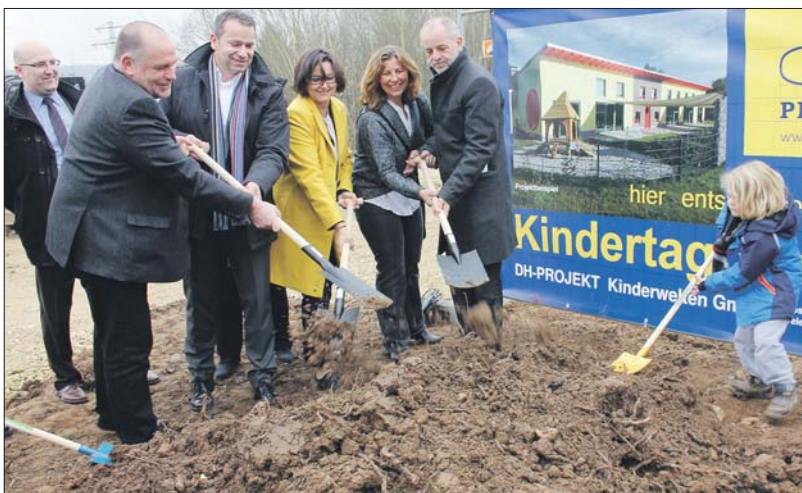
Baubeginn. Uwe Klimczak (3 AvR Rheinland-Pfalz Grundstück Verwaltungs GmbH), Gerd Willems (Kita-Trägerverein), Stephan Schröder (JTI), Angelika Winter (Lokales Bündnis für Familie), Inge Wanken (Leiterin Krabbelstube) und Oberbürgermeister Klaus Jensen (v. l.) greifen zum Spaten. Jetzt beginnt der Bau der Kindertagesstätte. Foto: PA
