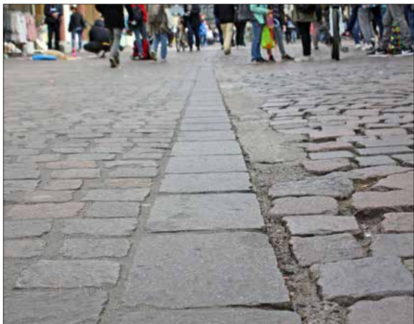
Geteilt. Der Unterschied zwischen dem bereits erneuerten Pflaster links und dem alten, das ab 24. April ersetzt wird, ist offensichtlich. Foto: PA
