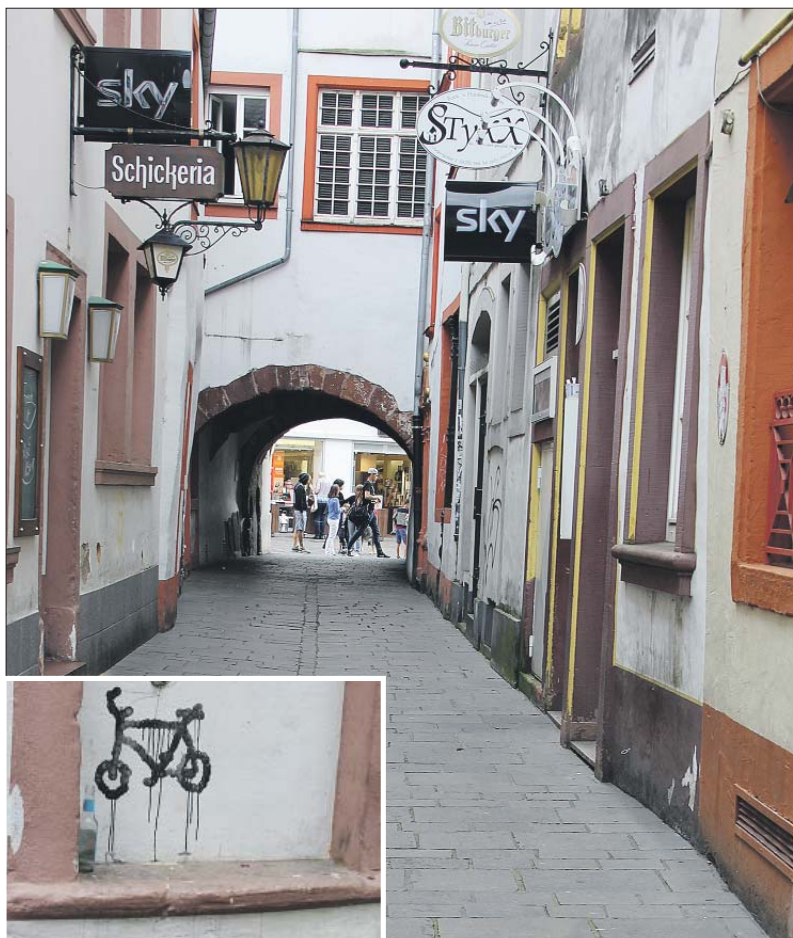
Vernachlässigt. Die Experten monieren den schlechten Zustand der Gebäude der historischen Judengasse im Stadtzentrum. Er wird durch Graffiti und illegale Müllentsorgung (kl. Foto) weiter verschärft. Fotos: Sandra Schmitt
