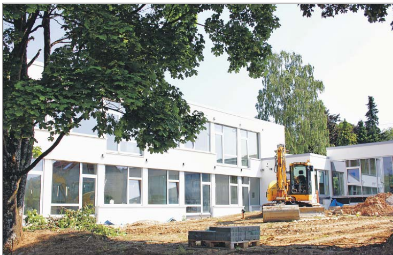
Mehr Platz für die Kinder. Das Gebäude der ehemaligen Tarforster Grundschule wird bis Herbst saniert und vergrößert. Foto: PA
