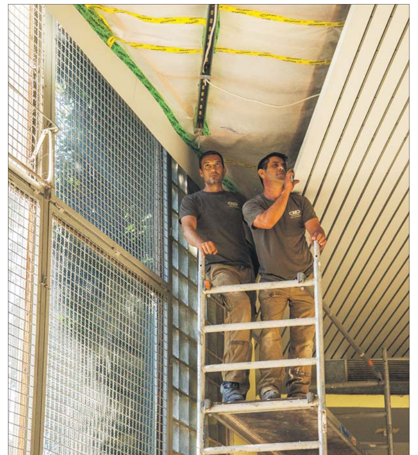
Hoch hinaus. Mitarbeiter der Firma CWD Bausanierung überprüfen und sanieren die Sporthallendecke der Medard-Förderschule. Die Arbeiten laufen nach Plan. Foto: Presseamt
