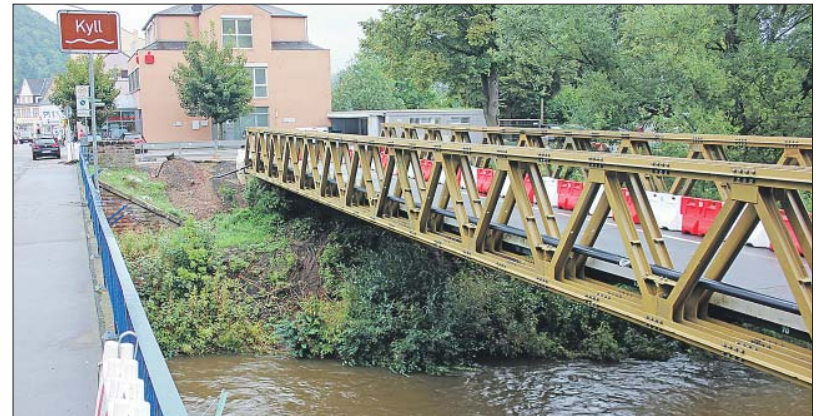
Parallele. Blick von der alten Kyllbrücke auf den provisorischen Überbau.
