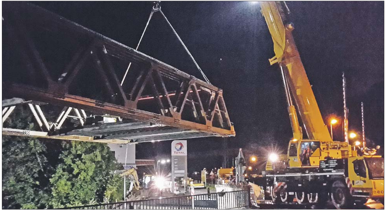
In der Schwebe. Die Behelfsbrücke hängt am Kran.
