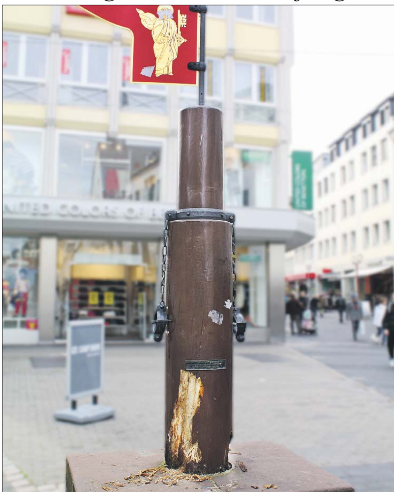
Der Holzstamm des Prangers in der Grabenstraße weist gravierende Schäden auf. Aus Sicherheitsgründen wird er daher umgehend abgebaut und soll erneuert werden. Bei dem 1979 aufgestellten Denkmal handelt es sich um einen Nachbau des historischen Prangers, der dort bis ins 19. Jahrhundert stand. Im Zuge der vollständigen Sanierung 2004 war auch der Holzstamm ersetzt worden. Foto: PA
