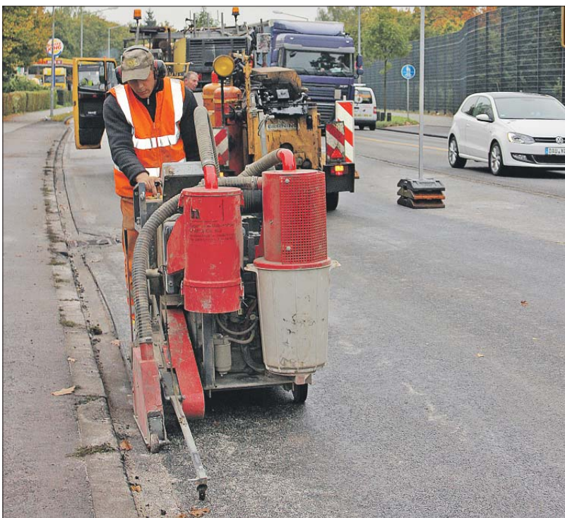
Kantenschnitt. Auf der frisch aufgetragenen Fahrbahnchicht der Zurmaiener Straße begradigt ein Bauarbeiter die seitliche Kante. Die Arbeiten wurden trotz wechselhaften Wetters sogar etwas früher als geplant abgeschlossen. Foto: PA
