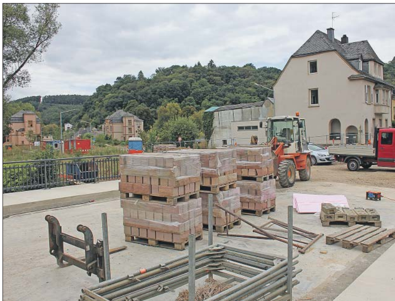
Rübergemacht. Der Bau der neuen Kyllbrücke 2015/16 war eines der größten Investitionsprojekte im Sanierungsgebiet Ortskern Ehrang. Im Hintergrund ist das ehemalige Mühlengelände zu sehen, über das jetzt die Umgehungsstraße verläuft. Archivfoto: Presseamt
